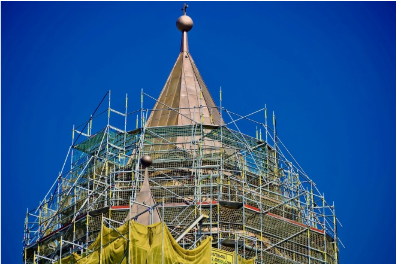
Kirche im Umbau
