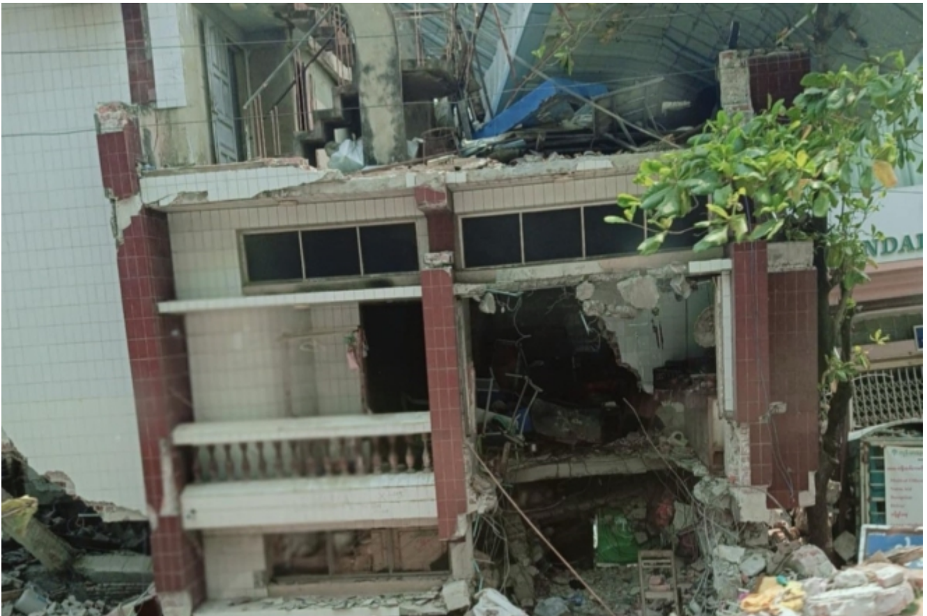
Zerstörtes Haus nach dem Erdbeben
